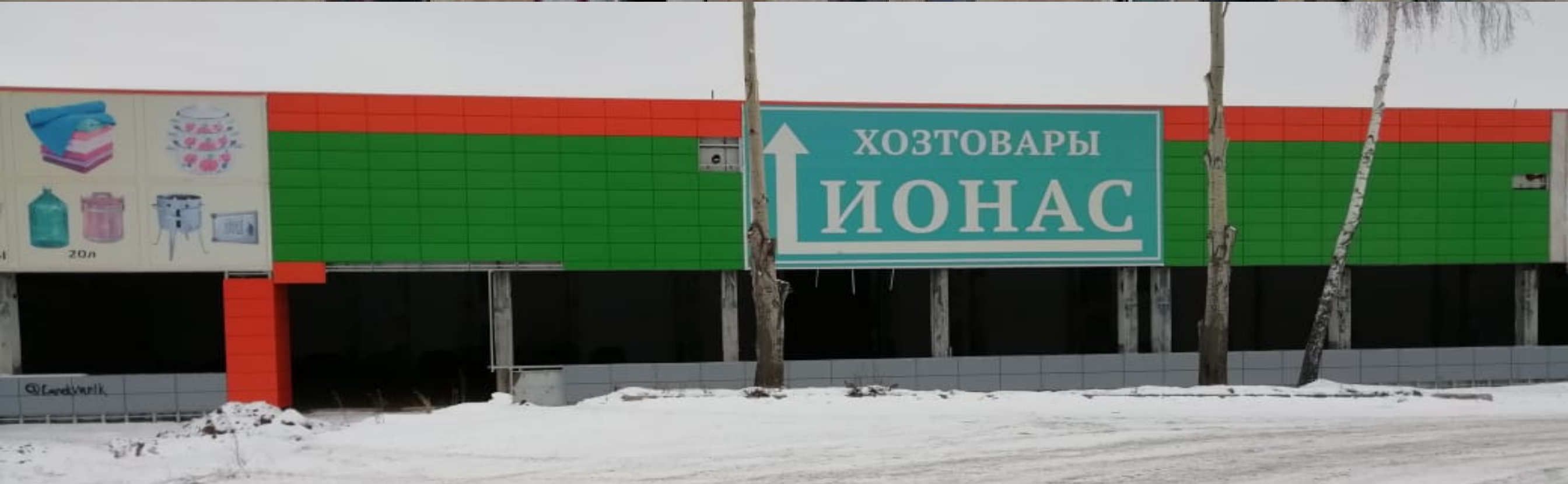
Реконструкция здания, расположенного по адресу: г. Октябрьский, ул. Северная, 68, в объект торговли-магазин
